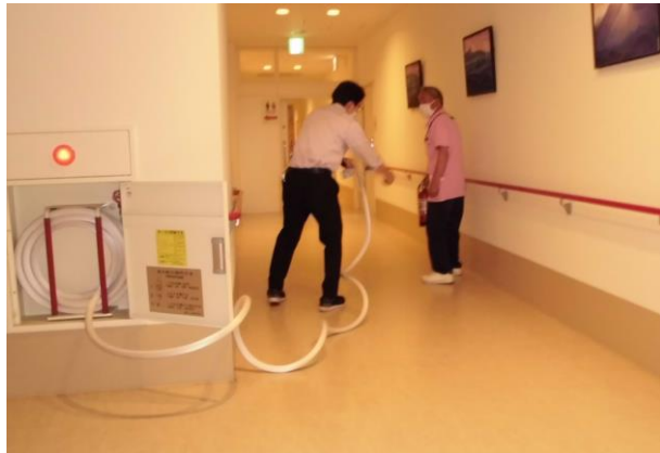
初期消火(消火栓)
